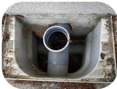
Cour anglaise côté sud avec raccordement sur conduit PVC
