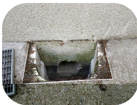
Cour anglaise côté sud avec raccordement sur conduit PVC
