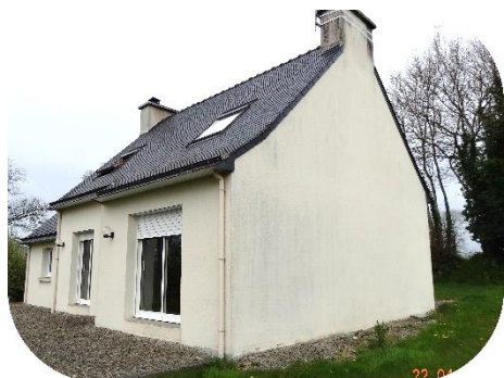
Vue extérieure façade sud, terrasse en cours de finition (graviers)
