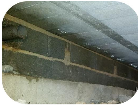
Arrivées réseaux non étanchées
