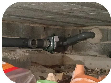
Ventilateur d'extraction hélico centrifuge du VS
