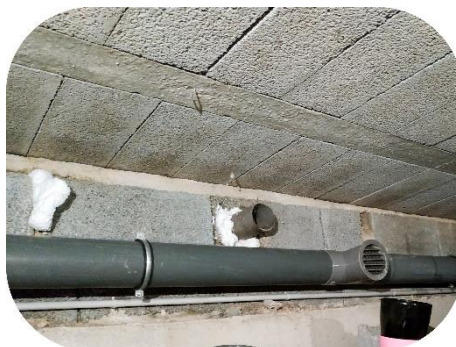
Réseau d'extraction du VS et ancienne aération obturée
