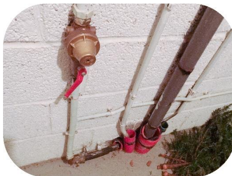
Arrivées réseaux non étanchées
