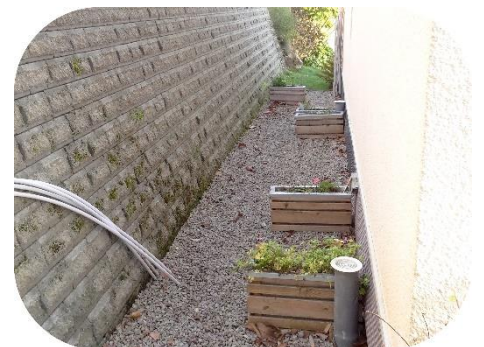
Mur pignon décaissé et drainé
