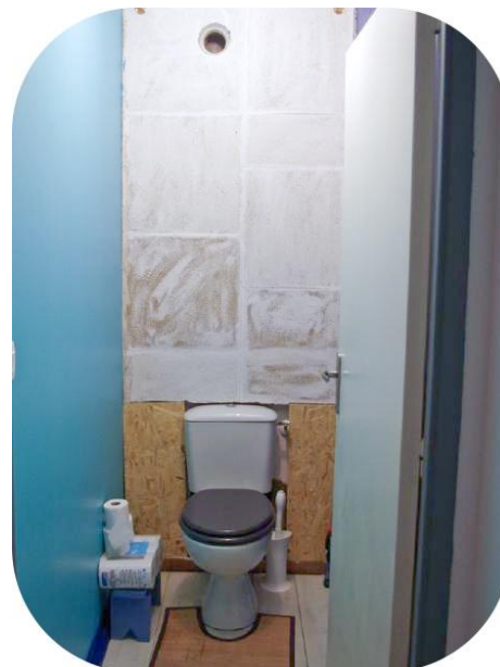
Cloison de la gaine technique derrière les WC
