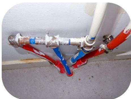
Fourreaux des réseaux EF/ECS non étanchés dans la cuisine
