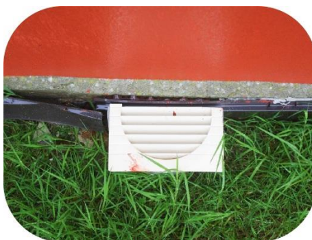
Grille de ventilation sous-dimensionnée du VS de l'immeuble
