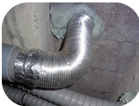
Raccordement du poêle sur un conduit d'amenée d'air extérieur
