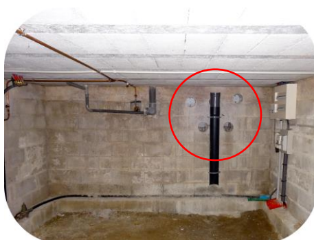
Ouvertures de ventilation du vide sanitaire
