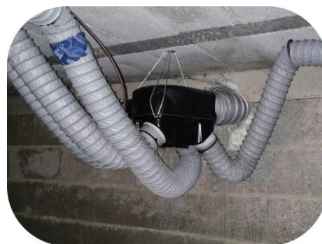
Amenée d'air extérieure pour le poêle
