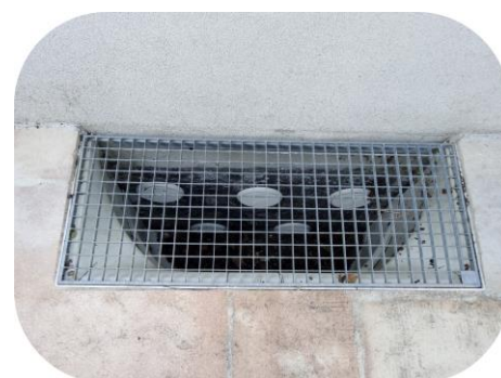
Ventilations du vide sanitaire (vue extérieure de la cour anglaise)
