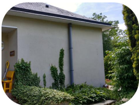
Conduit d'évacuation et sortie en toiture de la ventilation du VS
