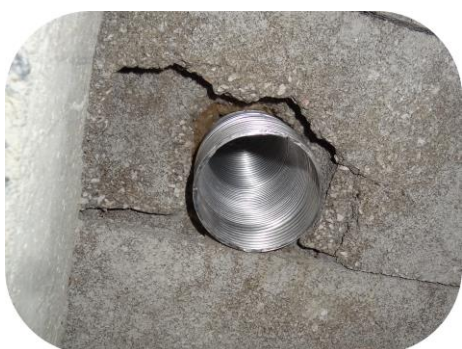
Prise d'air pour le poêle dans le vide sanitaire
